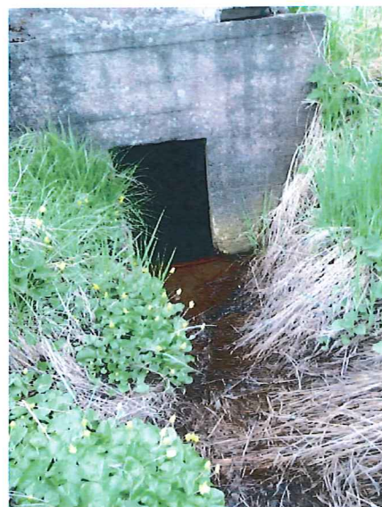
Inlopp i kulvertterad dagvattenledning.
