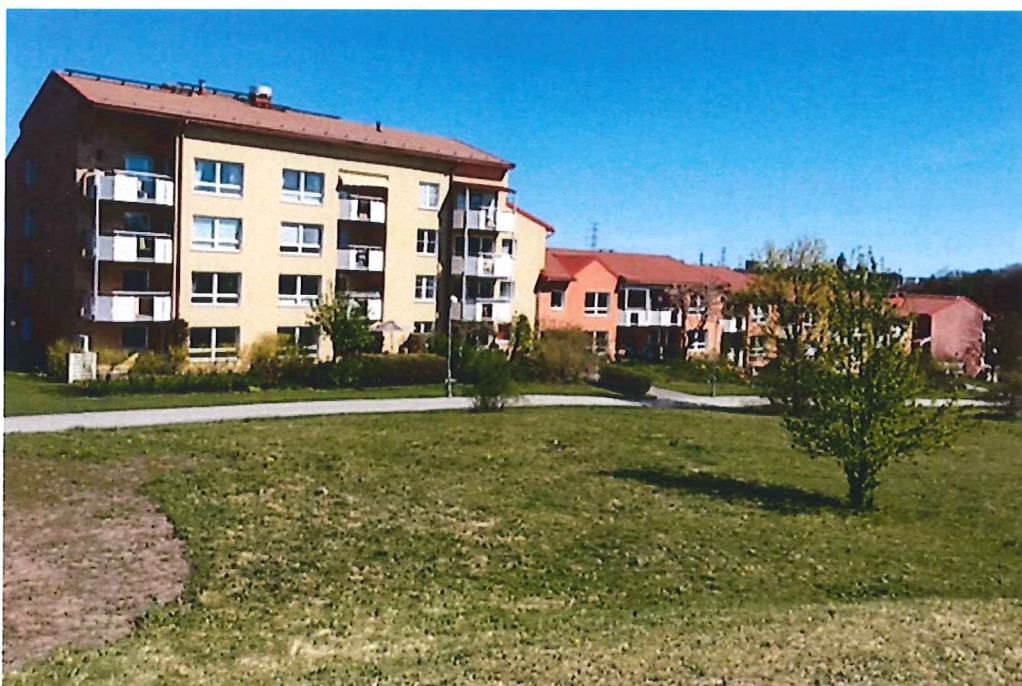
Hus E11, Bergshamra Allé 151-175 närmast i bild
