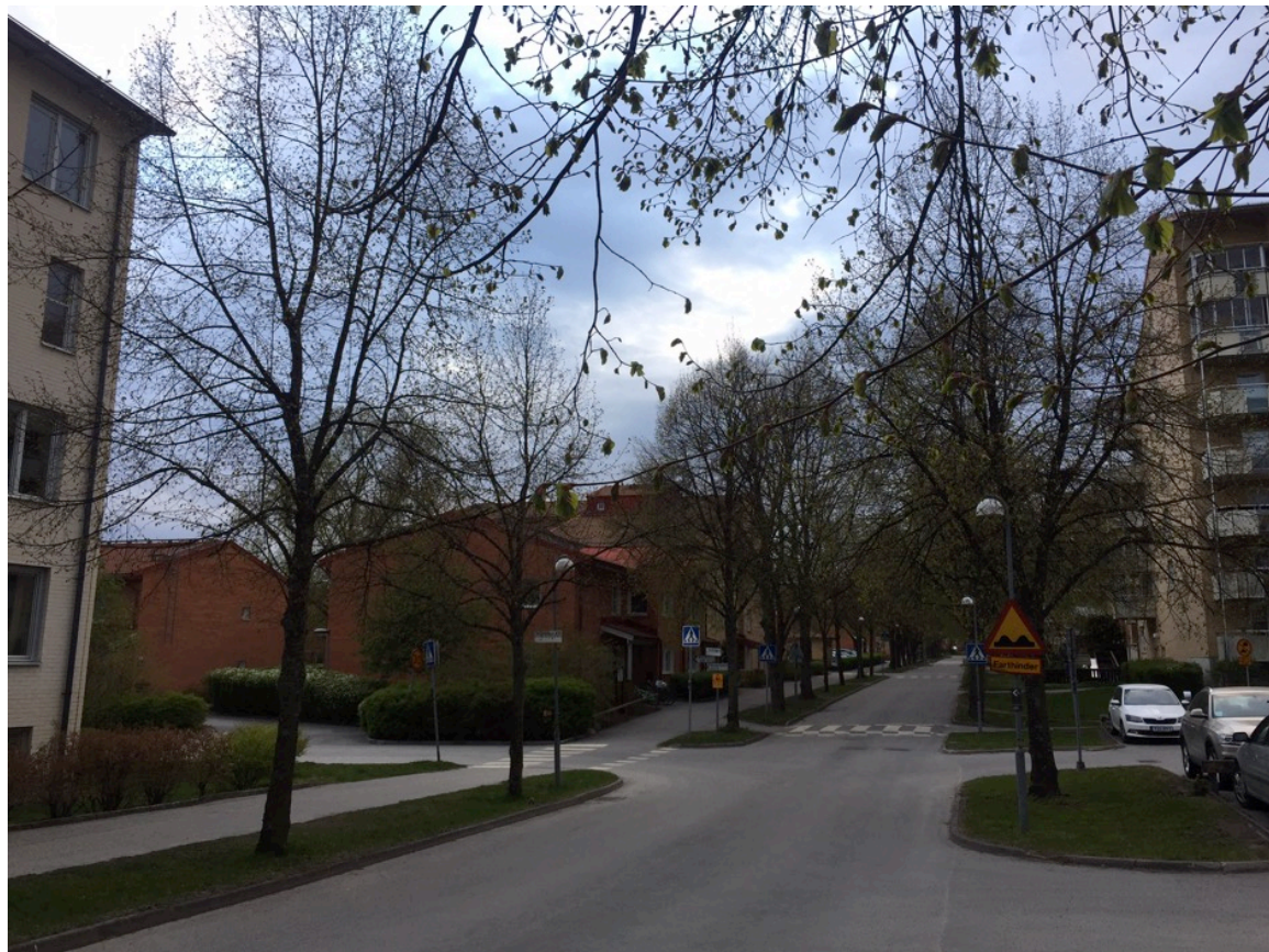
Figur 2: Foto taget från position 1. Vy längs Bergshamra Allé österut mot hus E1 i rött och gult tegel där byggnader på fastigheten Kornet 1 (vitt tegel) syns till vänster i bild och Rågen 10 (gult tegel) till höger.
