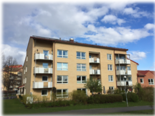
Figur 1: Det är bland annat på denna byggnad som solpanelerna ska läggas. Betongpannorna på det flacka taket syns inte från omgivande gång- och cykelvägar.
